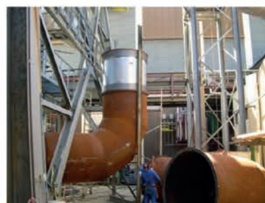
Conduit de fumée
